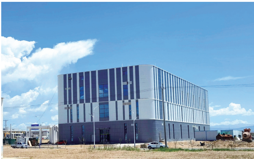
海南州数据中心厂房之一。 拍摄 / 张宁国
