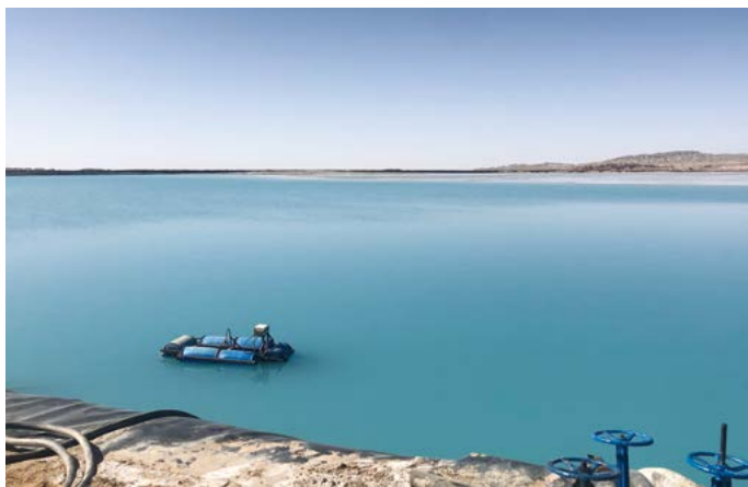
大柴旦矿业有限公司4号尾矿库中水回用池。摄影/李贝贝
